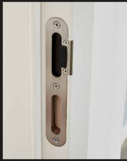
Detail: Magnetfallschließblech zum Verstellen
